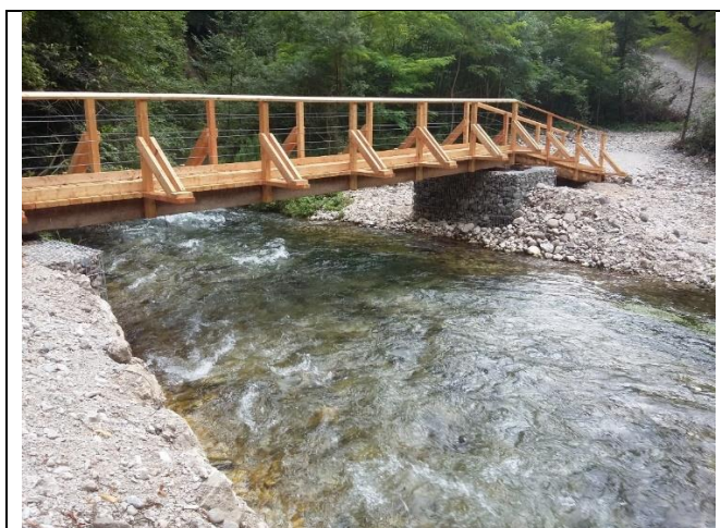
La passerella realizzata sul Fiume Noce
