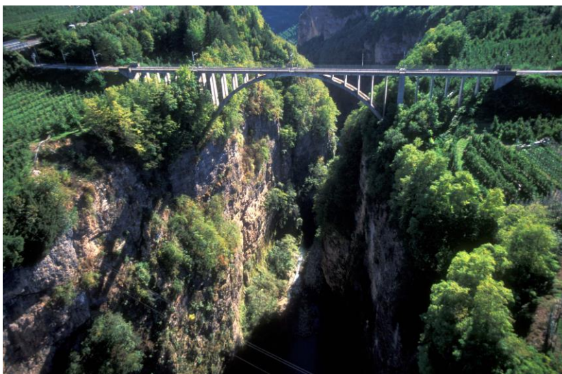
Foto aerea. Vista del ponte ferroviario
