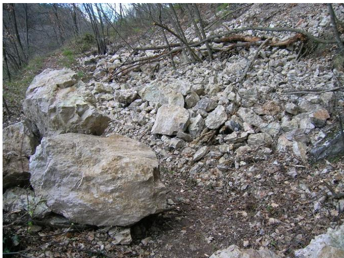
Tratto del sentiero investito dalla frana ed in parte liberato.
